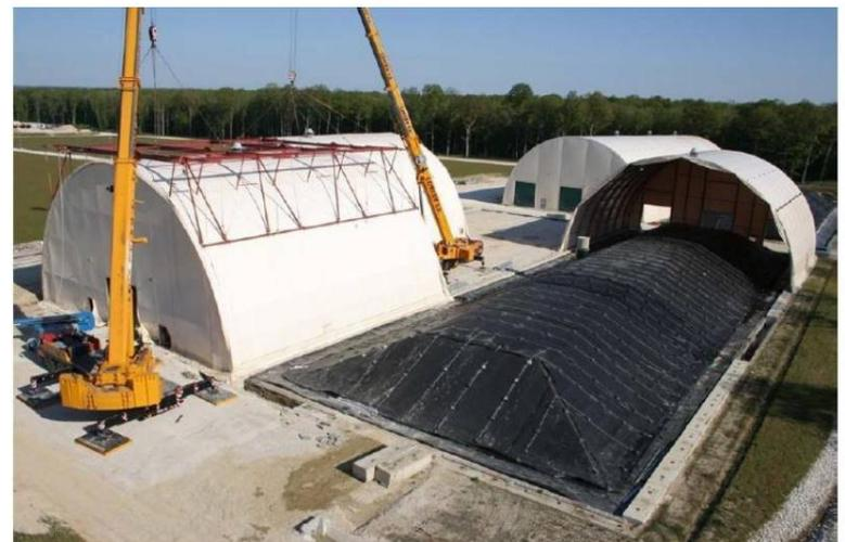
Emplacement de la couverture imperméable
